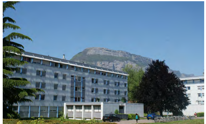
Le Crous Grenoble-Alpes recevra 26 millions d'euros pour la rénovation de ses bâtiments - Grenoble, résidence Ouest © Crous Grenoble Alpes
